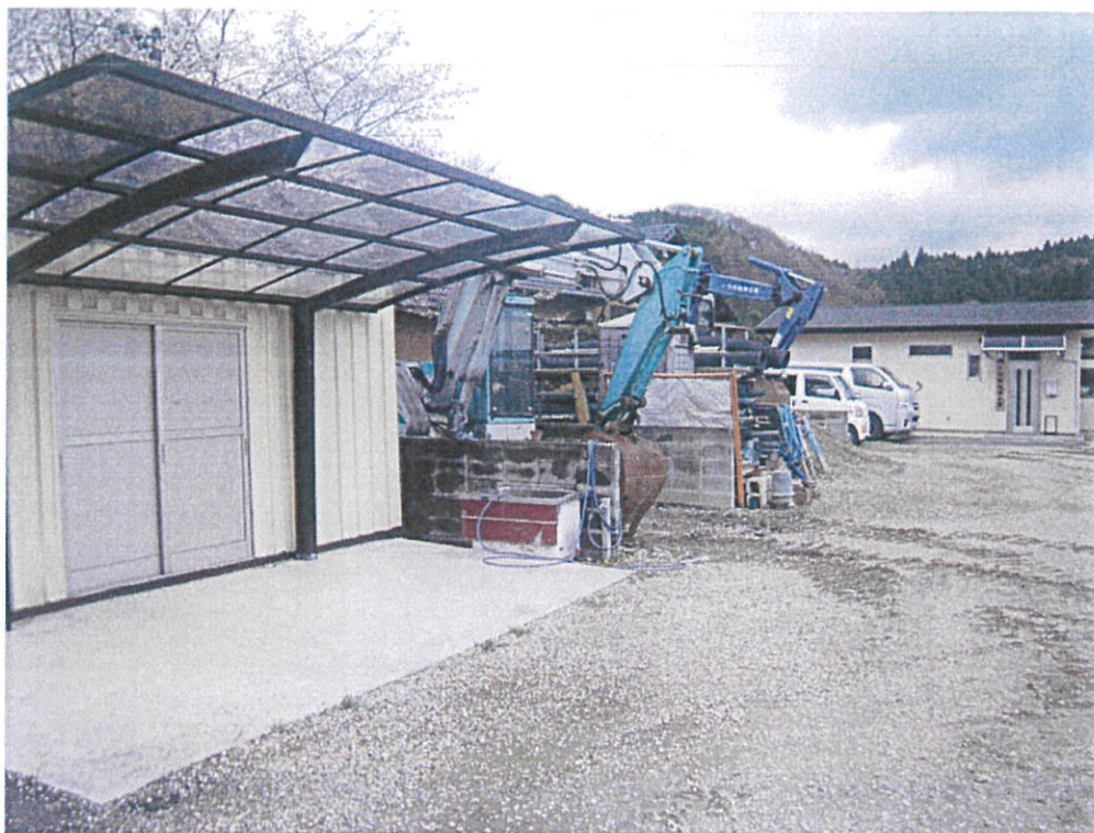
【写真タイトル】竹田設備工業 営業所、倉庫 【撮影箇所】奈良県宇陀市大宇陀五津169-1
