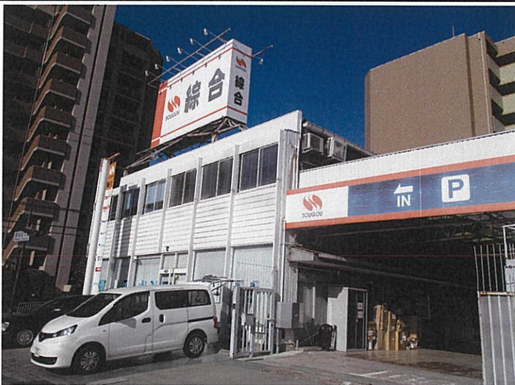
駐車場入り口付近
