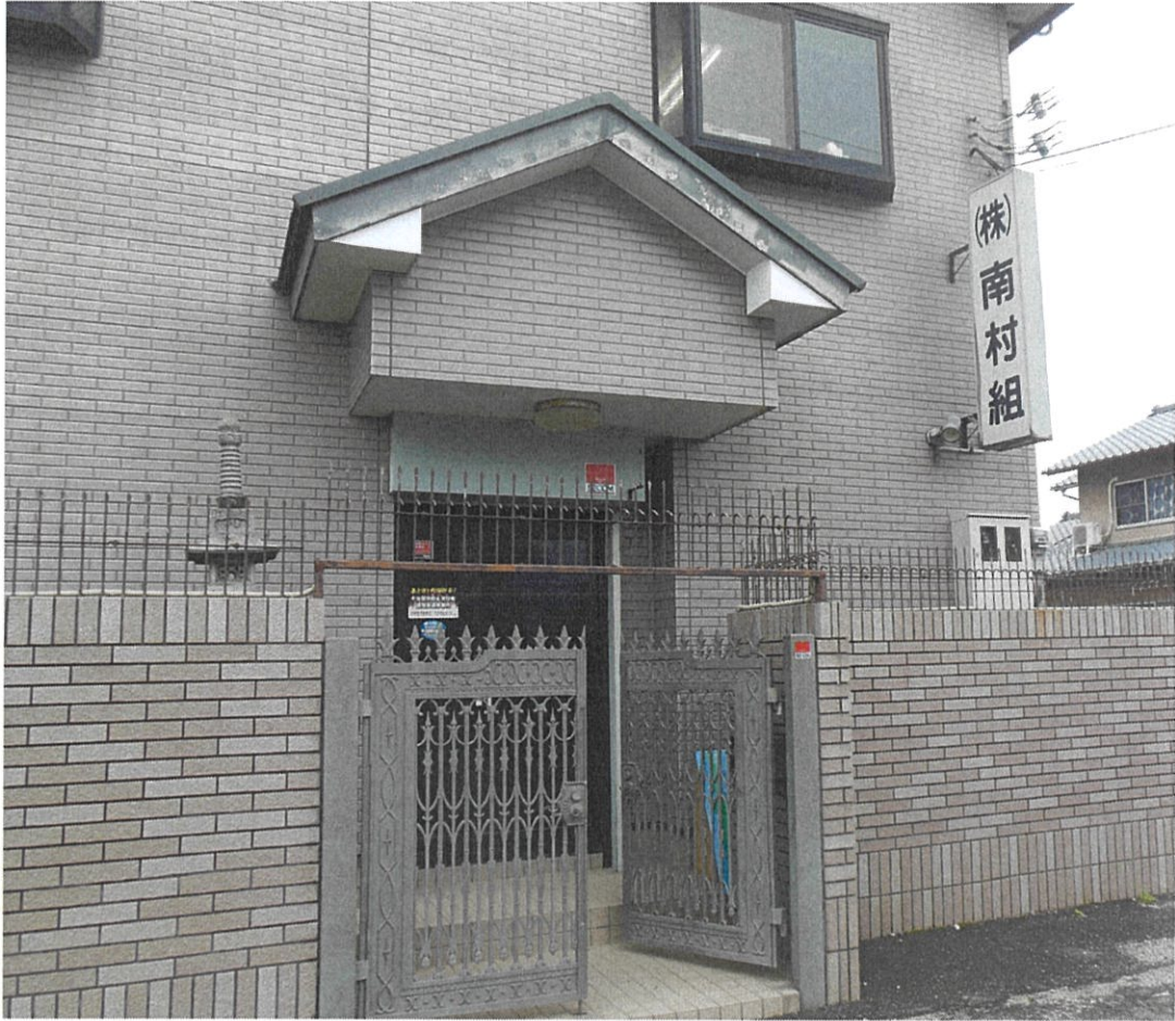
事務所の写真（外観）
