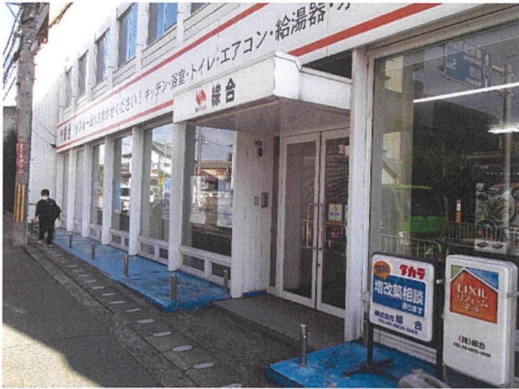
正面玄関付近
