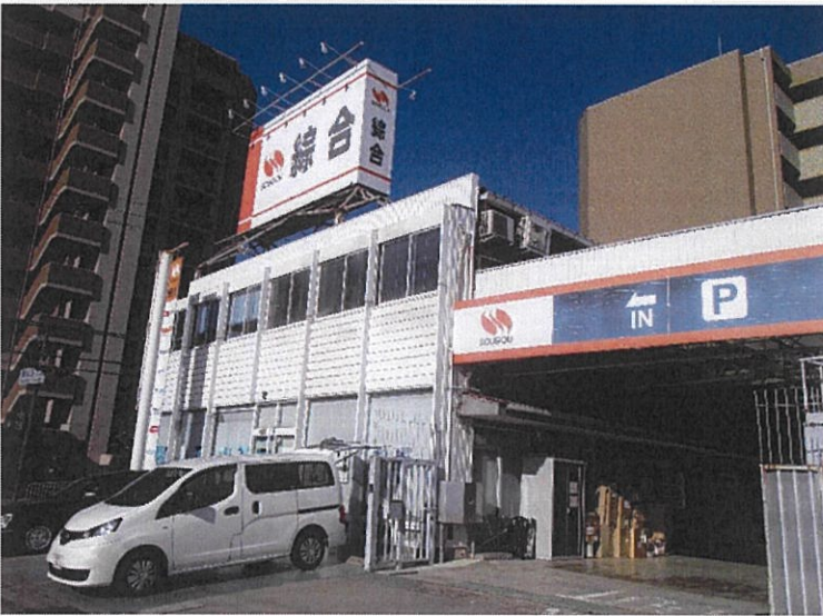
駐車場入り口付近
