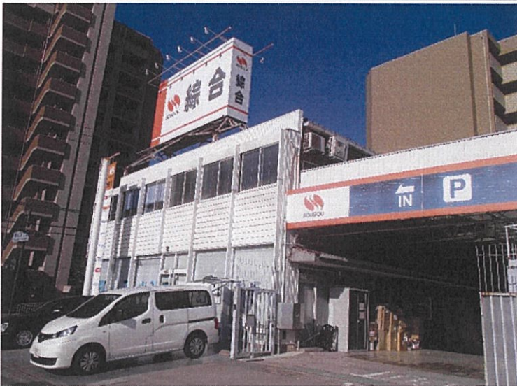
駐車場入り口付近
