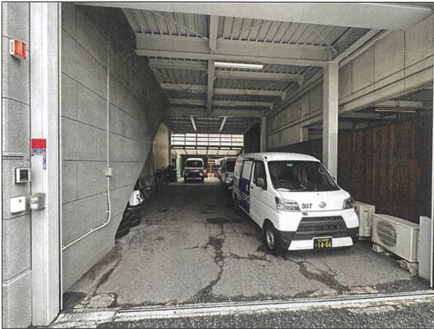
1F 駐車場・倉庫
