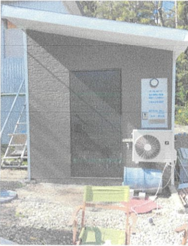
1階事務所 外観
